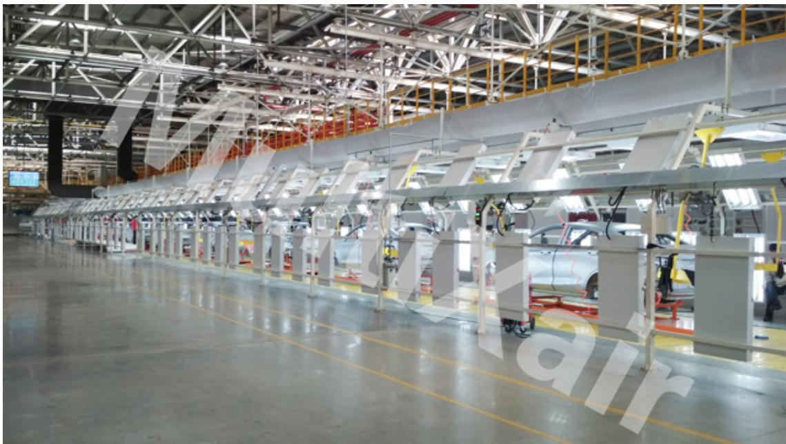
空间高度大于5m且体积于1万m<sup>3</sup>的建筑被称为高空间建筑。部分工厂车间、医药高架库、体育馆等均属于高空间，高空间是普遍采用布风管送风的场所之一。对于有观众席的型体育馆，多围绕观众席设计专门的送风管道系统。对于平顶网架结构的体育馆设计，可在网架内空间允许的情况下将纤维布风管平均分配到网架内。对于设有马道的空间体育馆，都是网架架构的屋顶MX纤维布风管系统可沿着马道两边布置或者布置在网架之内，这样不节省了空间提高了美观度，还方便安装拆卸和检修。上海内支撑布风管图片布风管，就选米希（上海）环境技术有限公司，让您满意，有想法可以来我司咨询！
