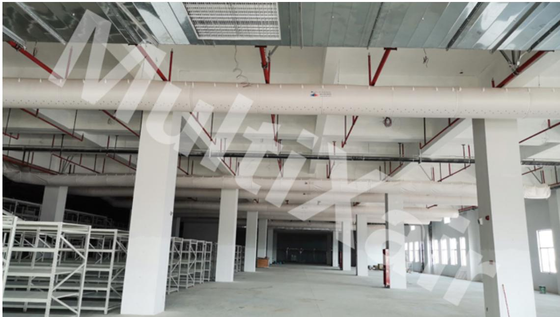
冷库中一种新型的送风方式是采用MX布风管，它是一种由特殊纤维织成的柔性空气分布系统，是集风口、送风管道、静压箱、保温材料、风阀等功能为一体的端送风系统。与传统金属风道系统相比，MX布风管送风具有送风均匀、无吹风感、干耗小、不结露、易清洁维护、重量轻等优点，还可以实现使用较小功率的电机实现较送风距离，节能性好，贴顶式安装还能增加冷库的容积利用率。MX布风管在冷库中应用，一种是高低温冷藏库，要求库内温度均匀，货物干耗小，一种是低温操作加工间，要求无吹风感，有良好的舒适性。
